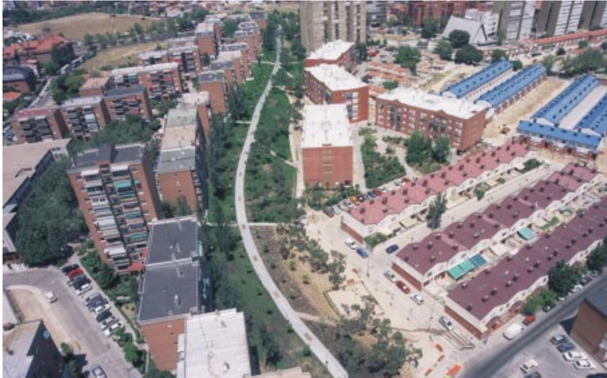
Foto aérea de la actuación
